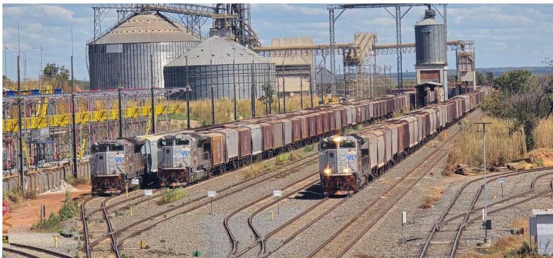
Foto 8 – Estrutura da VLI, conexão multimodal com a TO-335
