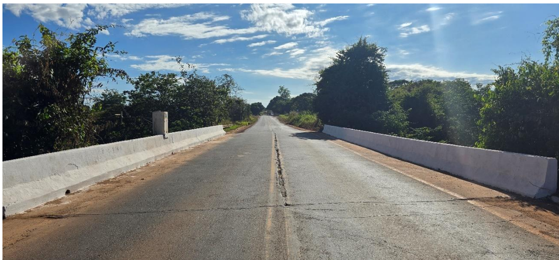
Foto 12 – Ponte sobre o ribeirão Lontra, transposição da TO-222
